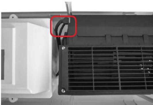
Fig. 7.4.2.6 : Raccorder le connecteur du ventilateur
