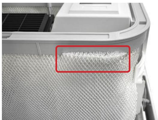
Fig. 6.3.2.5 : Mauvaise position du filtre
